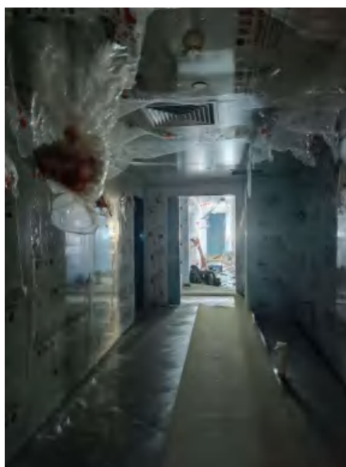
拟建3间机房楼上现状
